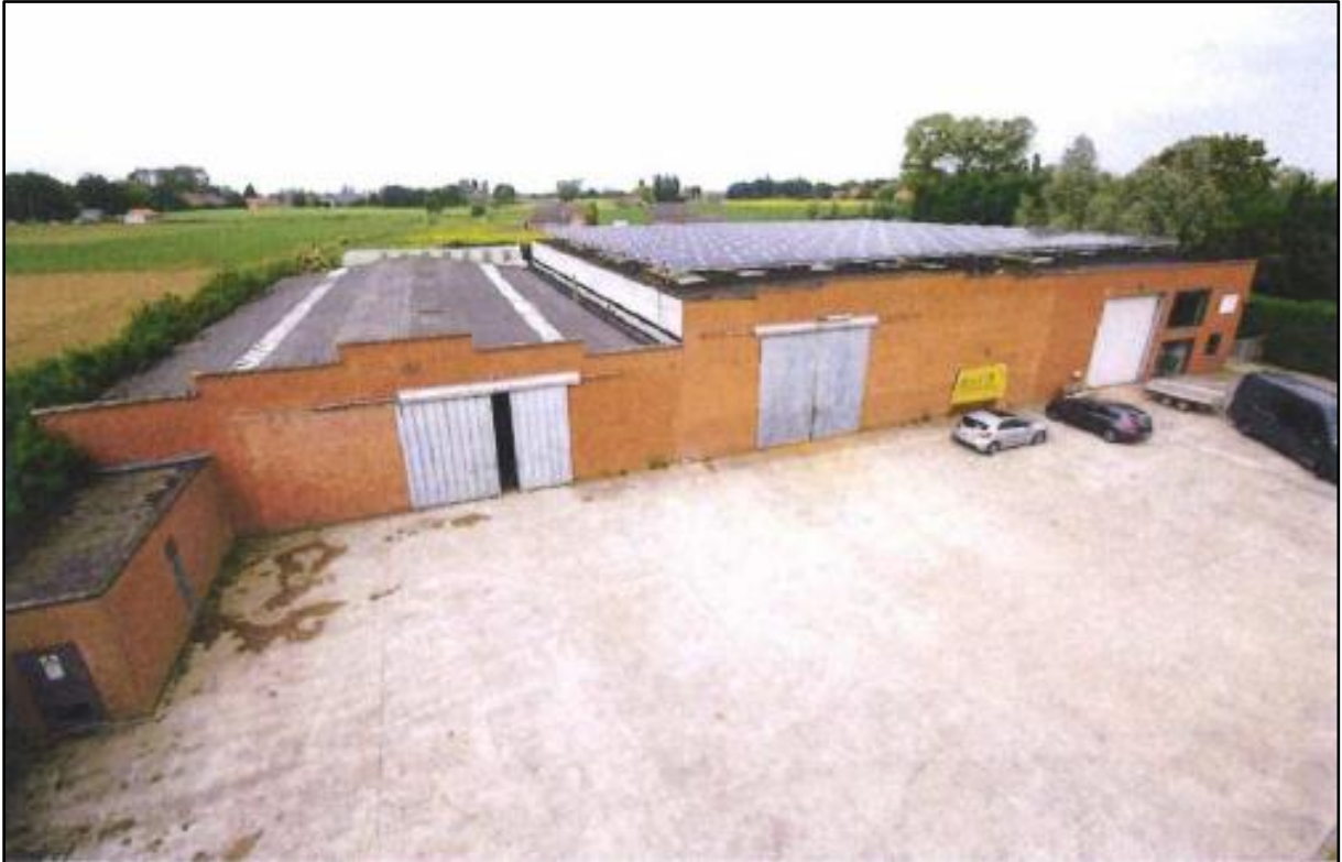
Figuur 2 Zicht op de voorzijde van het magazijn met kantoorruimtes aan de Weegschede 39B (bron: initiatiefnemer).
